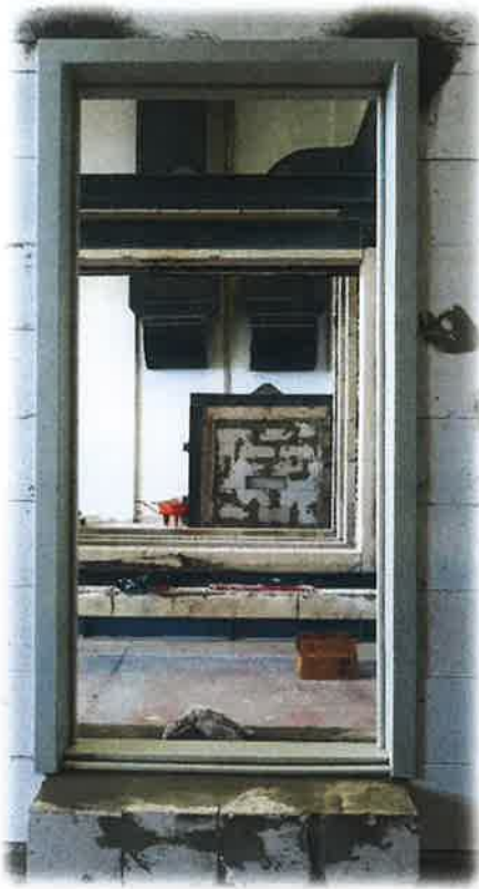
Şekil 10-11. Kasa İçerisine Uygulanan Dolgu Harcı
